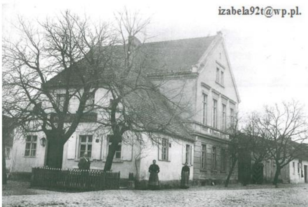
2. Babimost, Gasthof zur Sonne oraz W.Ulmitz Hotel, po 1875 (Archiwum prywatne Huberta Ulmitza). Widok od strony południowo- zachodniej. Na elewacji zachodniej widoczny szyld z nazwą gospody, na elewacji południowej nazwa hotelu.
