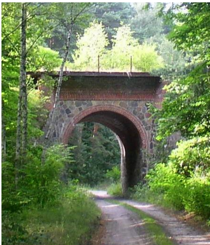
Wiadukt kolejowy nad drogą z Kolesina do folwarku Quelle.
