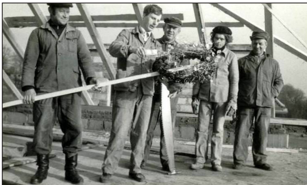
Cieśla Łucjan Sobota z pomocnikami zawiesza wiechę po zakończeniu budowy konstrukcji dachu - lata 80 XX w.
