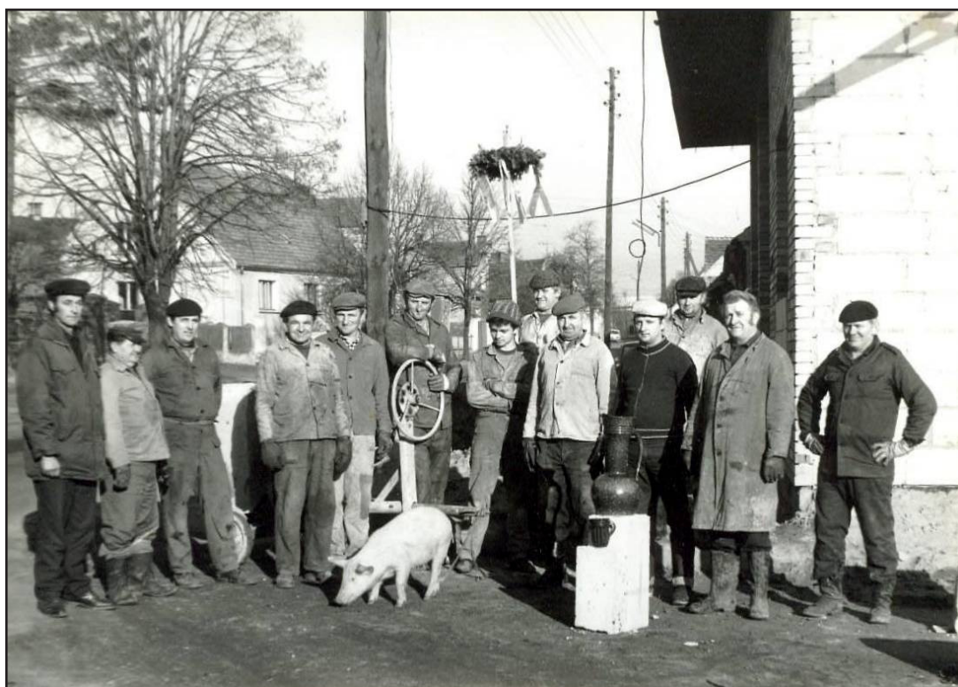
Zawieszenie wiechy na dachu budowanej w czynie społecznym remizy strażackiej w Nowym Kramsku - 1986 r.
