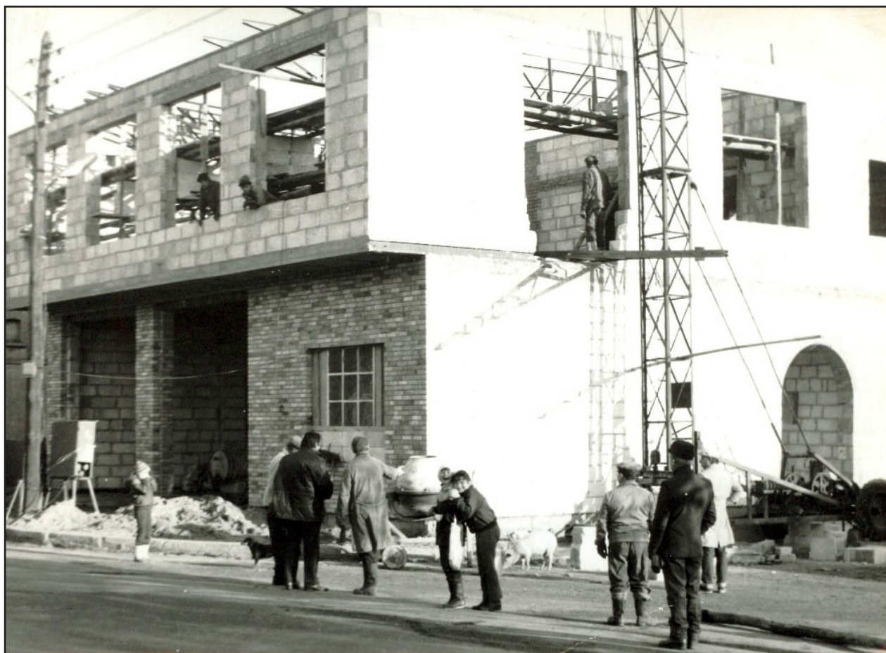
Praca społeczna przy budowie remizy strażackiej w Nowym Kramsku - 1986 r.
